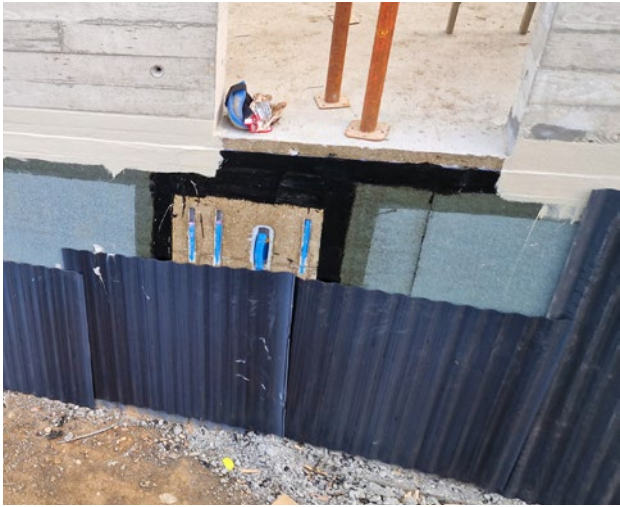
Sopra, impermeabilizzazione interrata contro l’acqua di falda: i manti bituminosi impediscono infiltrazioni, ma anche la corrosione del calcestruzzo e i flussi di vapore (umidità) verso l’interno. Sotto, villa d’inizio ‘900: le murature antiche – ma anche quelle moderne – a contatto col terreno prima o poi assorbono acqua; è questione di tempo.
